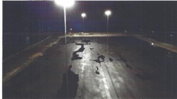
Pavimentación y Superpostos en Plataforma 8
