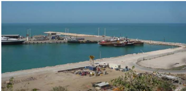
Actualmente se realiza el proyecto de ampliación del puerto de Seybaplaya que consiste, en una primera etapa, en la construcción de 3.5 km de viaducto con un ancho de corona de 11m y la construcción de una plataforma operacional de 7 ha, alcanzando una profundidad de -6 m, con 400 m de muelles incluyendo bitas y defensas marinas, así como toda su infraestructura de servicios. La segunda etapa consistirá en la
